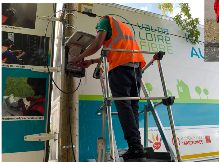
Stagiaire réalisant un raccordement aérien avec le plateau TDF Groupe POEC AFPA de Blois 41 - printemps 2022
