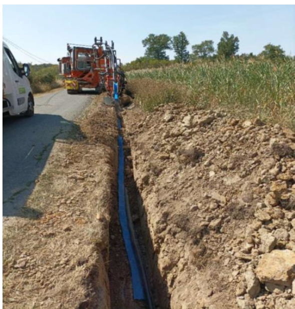
Renouvellement des conduites CVM à Bossée
