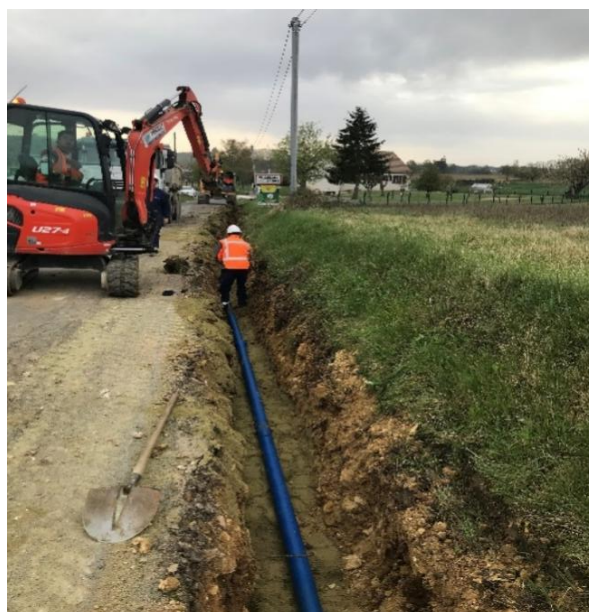
Renouvellement des conduites fuyardes à Villeloin-Coulangé
